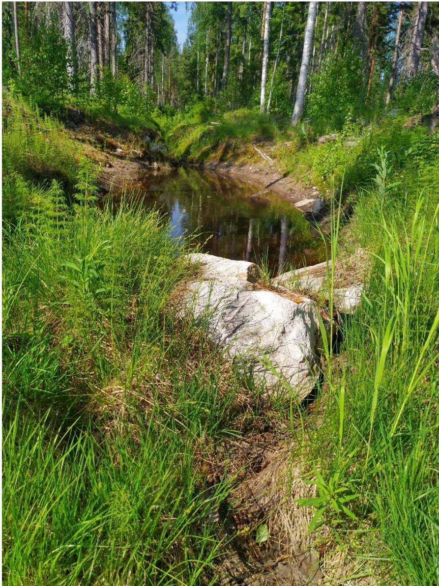
Kuva 4-6. Lietekuoppa ja sen kivikynnys. Kuopan vesipinta-ala oli 20.6.2023 noin 17 m 2 .
