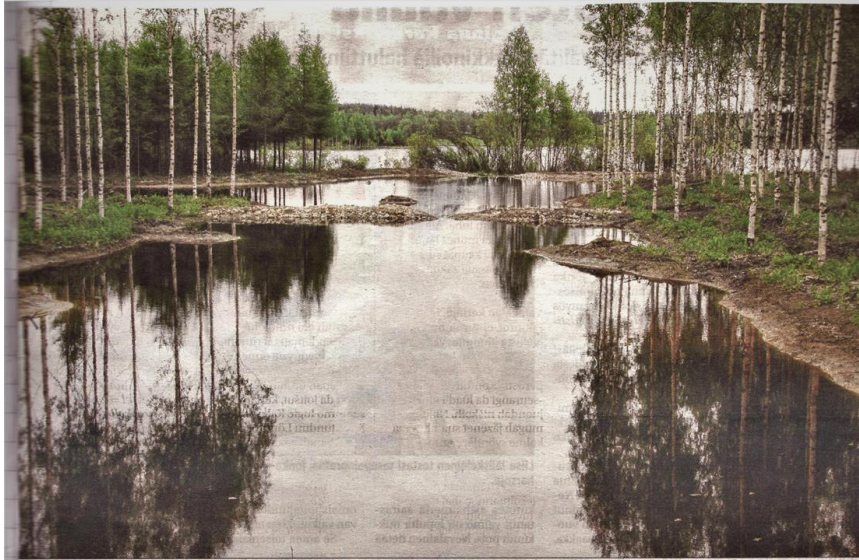
Kiintoaineiden ja ravinteiden pääteppysäkeiksi rakennetut laskeutusaltaat Pohjajärven yläpuolella ovat valmiit, ja puhdistunut vesi virtaa hiljalleen patorakennelmien yli kohti järveä. KUVA: TIMO KYLLÖNEN
